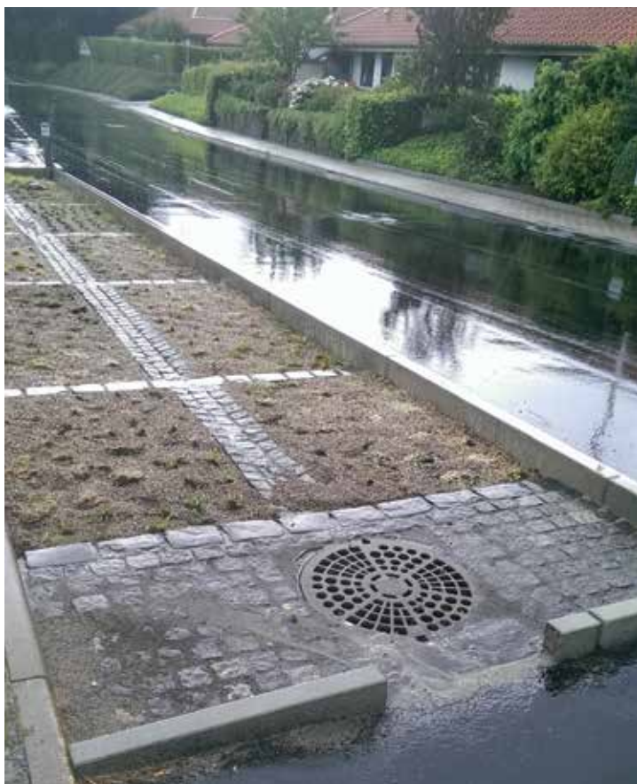
Regnbed indrammet af ParkLine Støttemur.
