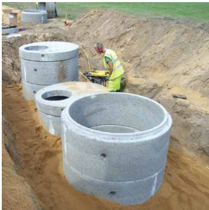
Etablering af strækning med PermaBrønde, Ikast.
