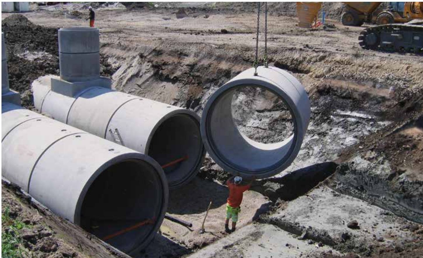
Etablering af bassinløsning med Ø2500 mm rør.
