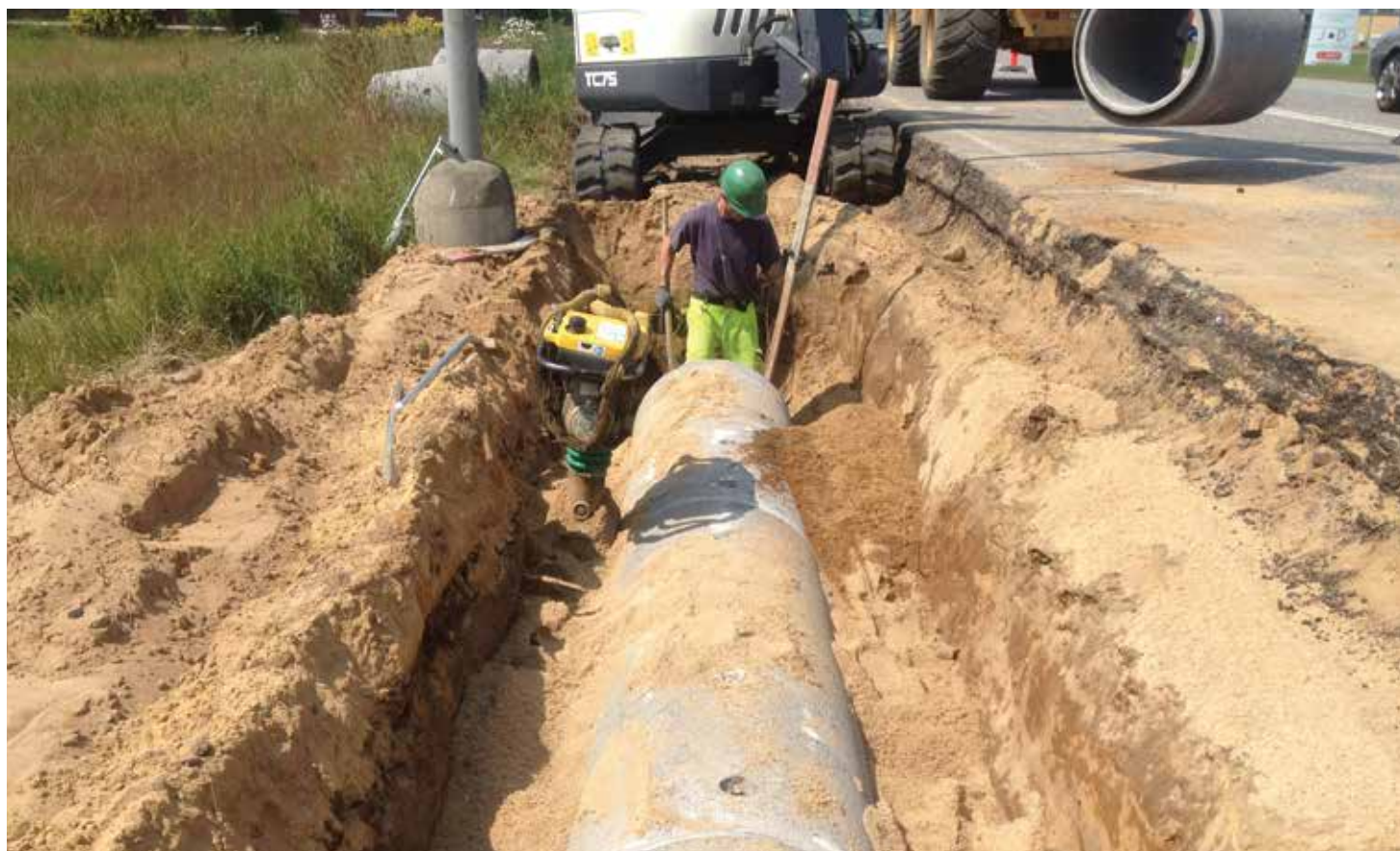
Etablering af strækning med Permarør, Ikast.
