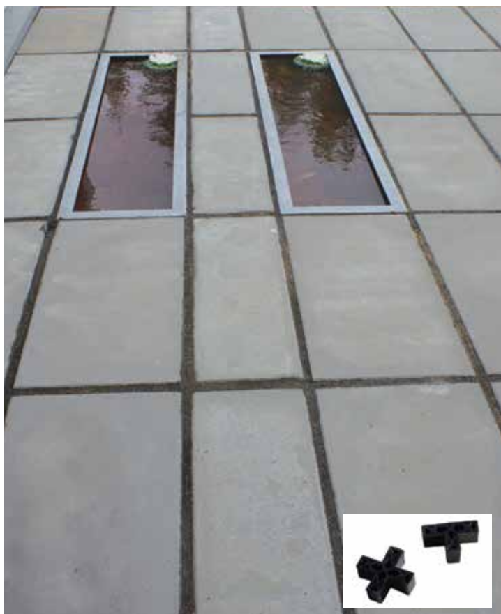
Standardfliser med fugekryds og permeable fuger.
