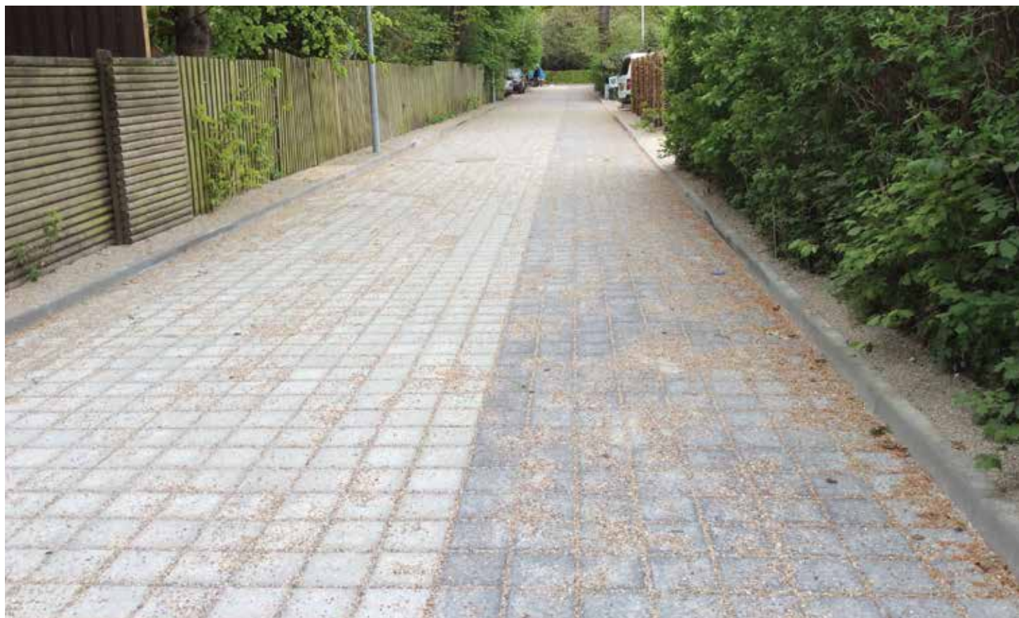
Permeabel boligvej, Helenevej, Frederiksberg.
