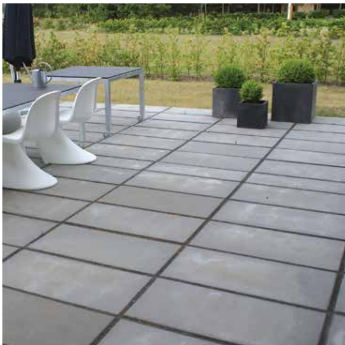
Standardfliser med fugekryds og permeable fuger.
