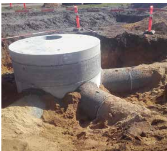
Regnvand ledes fra brønde til IBF Permarør for nedsivning.
